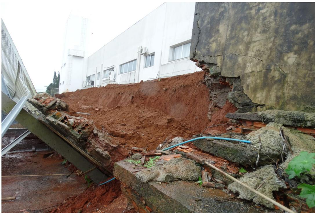
**Figura 3:** Deslizamento de terra ocasionado pela queda do muro.
