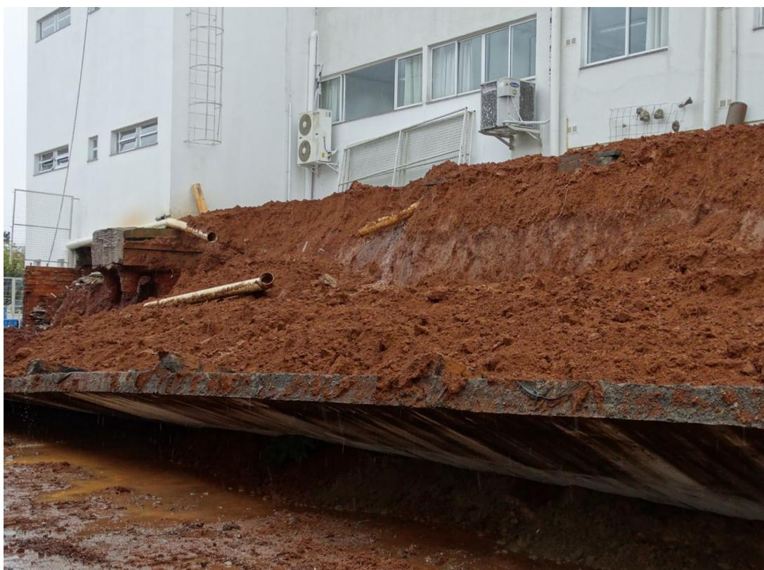
**Figura 4:** Detalhe dos danos ocasionados na tubulação de escoamento de água pluvial.
